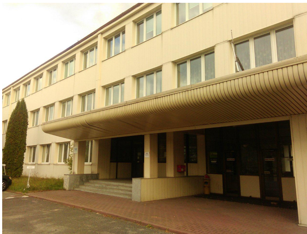
Rysunek 14: Budynek biurowca w Niewiadowie - stan obecny
