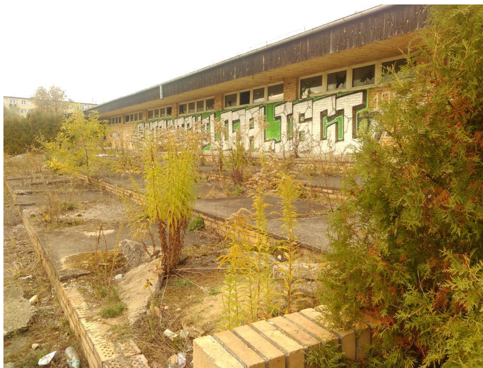
Rysunek 11: Obiekt nieczynnego basenu
