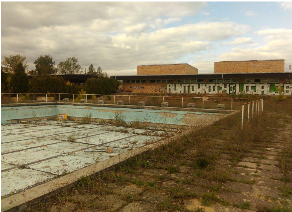
Rysunek 10: Obiekt nieczynnego basenu
