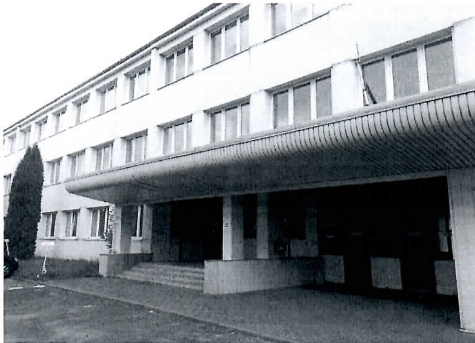
Rysunek 14: Budynek biurowca w Niewiadowie - stan obecny
