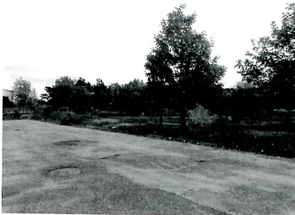
Rysunek 13: Teren przy Gminnym Ośrodku Kultury w Osiedlu Niewiadów
